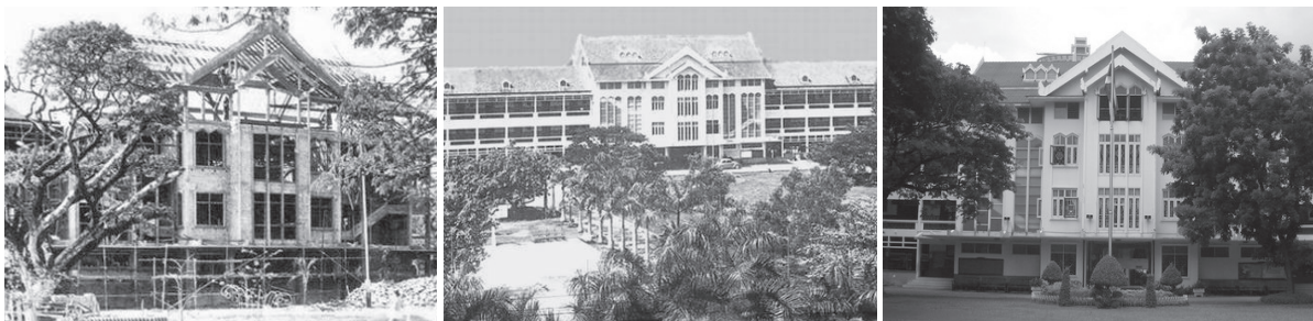
อาคารเรียนใหม่สร้างแล้วเสร็จในปี 2506 ปัจจุบันใช้เป็นอาคารเรียนประถมศึกษา
